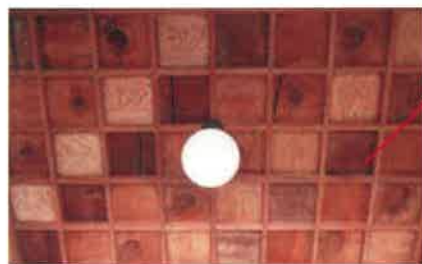
▲ 玄関天井の格天井 （よく見ると色の違いや節目がちどりに組まれている）
